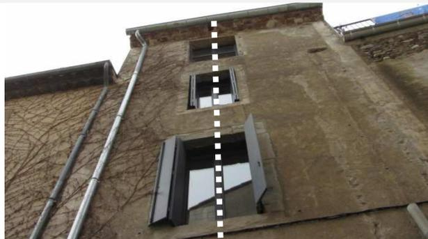
Il ressort que les ouvertures sont toujours dans le sens vertical (proportion se rapprochant de 1,6 entre la largeur et la hauteur). D'autres dimensions peuvent être envisagées si elles correspondent au rythme des façades existantes. Par exemple, la dimension carrée des fenêtres peut être acceptée pour les fenêtres de dernier niveau.
