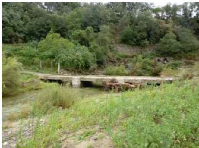
Figure 5 : passages à gué obstrués par des corps flottants sur le Rieutord amont (radiers de Mauplat et de Comessac)
