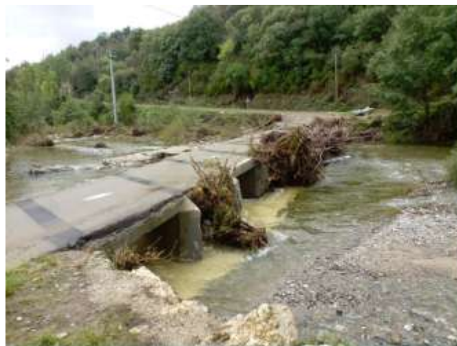
Figure 5 : passages à gué obstrués par des corps flottants sur le Rieutord amont (radiers de Mauplat et de Comessac)
