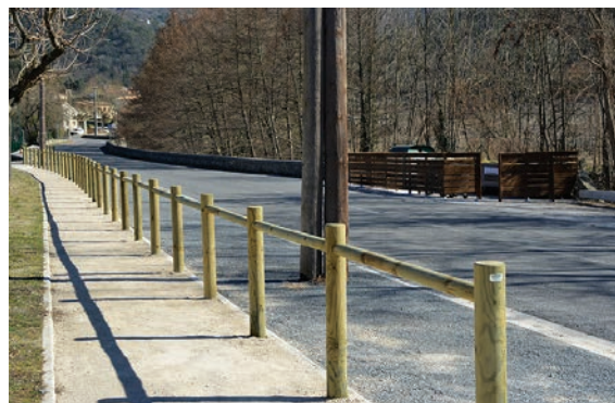
Mise en discrétion poubelles + rampe de sécurité
