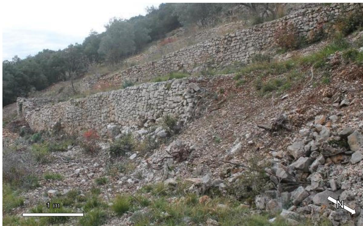
Figure 9 – Remplissage terro-caillouteux au niveau d'un effondrement de mur, au sud de la zone projet
